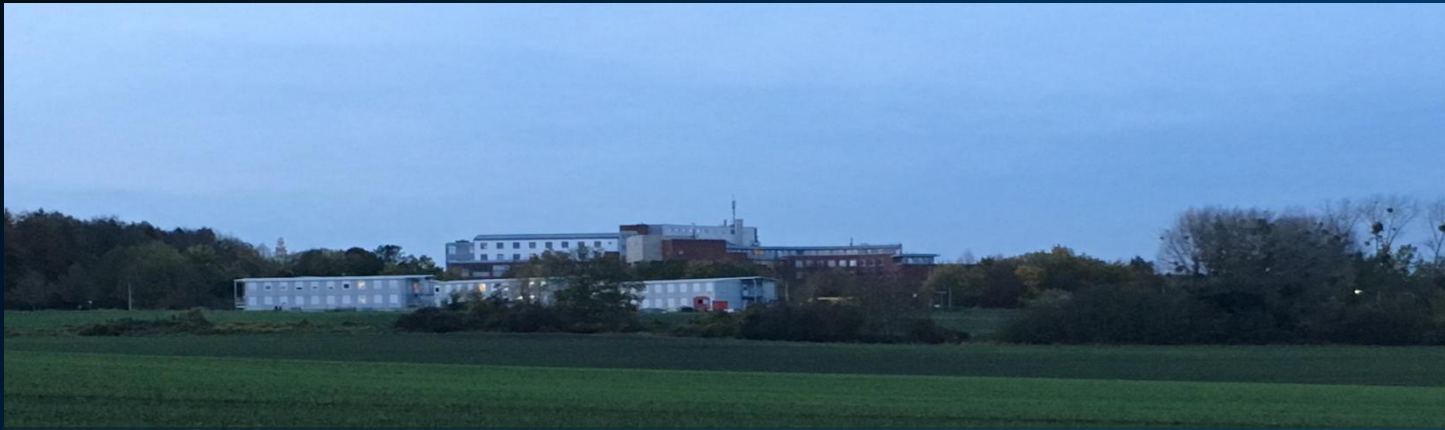
Containeranlage Brühl West
