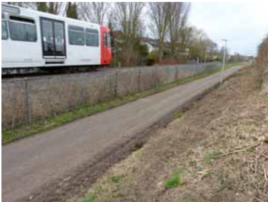
Ausbaustrecke mit Wohnbebauung Höhe Gesamtschule
