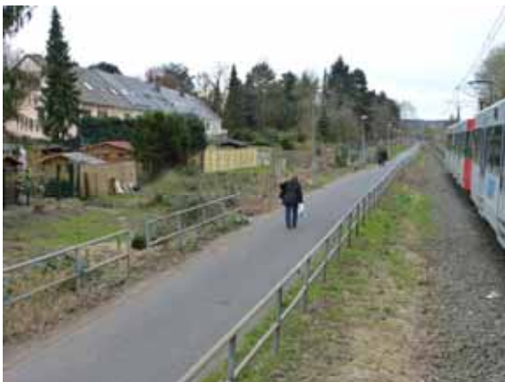
Ausbaustrecke mit Wohnbebauung süd. Pingsdorfer Str.
