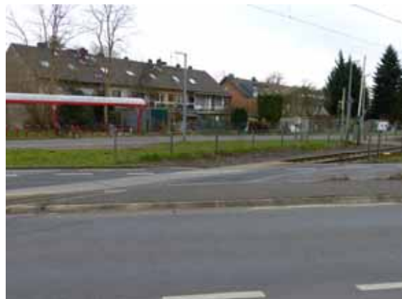
Ausbaustrecke mit Wohnbebauung Haltepunkt Brühl-Süd
