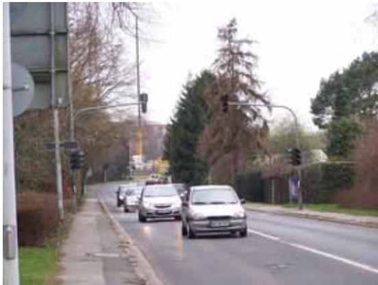
Theodor-Heuss-Straße, östlicher Abschnitt
