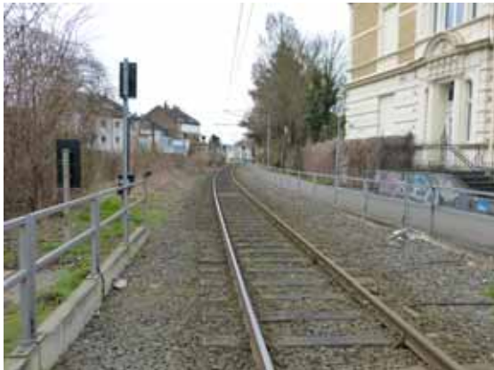
Ausbaustrecke Pingsdorfer Straße – Liblarer Straße
