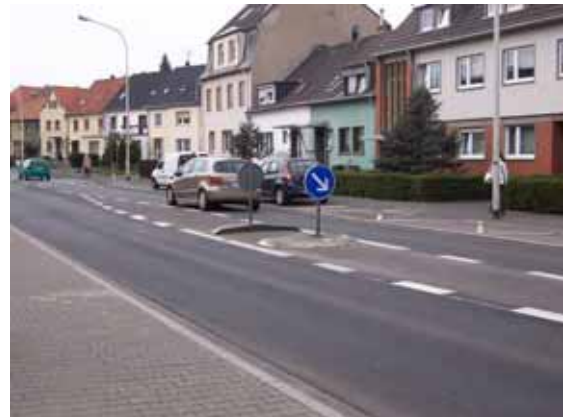
Provisorische Querungssicherung nördlich Chlodwigstraße
