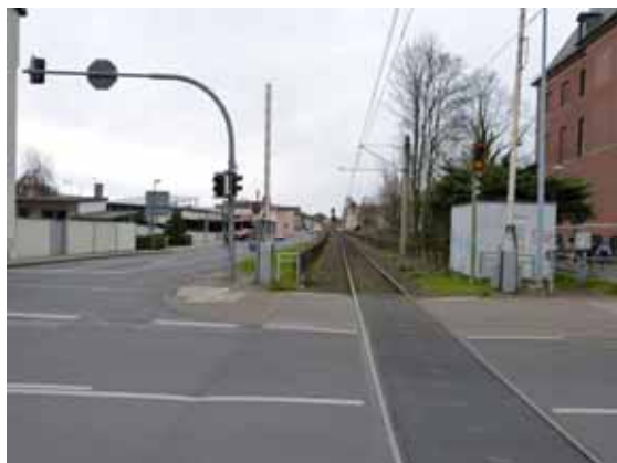
Bahnübergang Clemens-August-Straße mit Ausbaustrecke Clemens-August-Straße – Liblarer Straße
