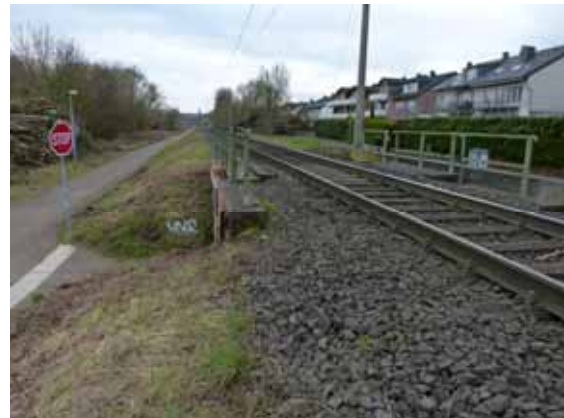
Ausbaustrecke mit Wohnbebauung Höhe Gesamtschule
