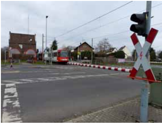
Brühl-Schwadorf, Bahnübergang Bonnstraße
