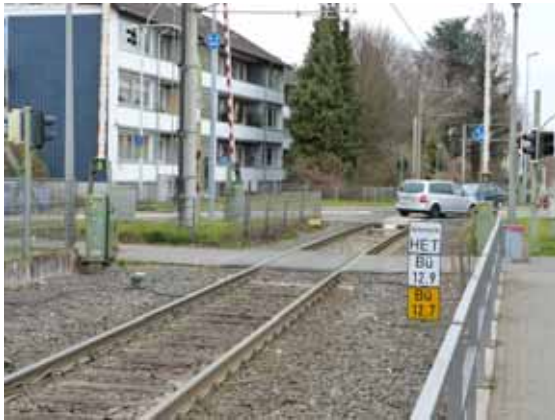
Bahnübergang Pingsdorfer Straße
