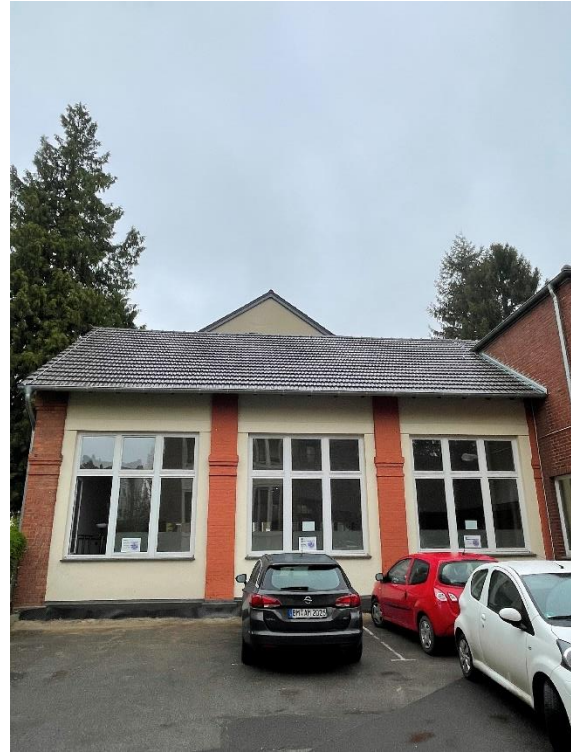
Abbildung 2: Südansicht Satteldach I
