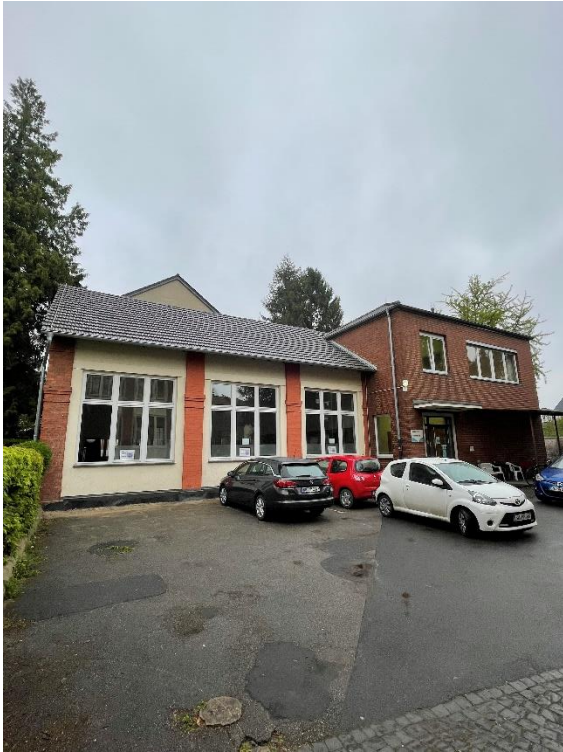
Abbildung 1: Südansicht des Gebäudes
