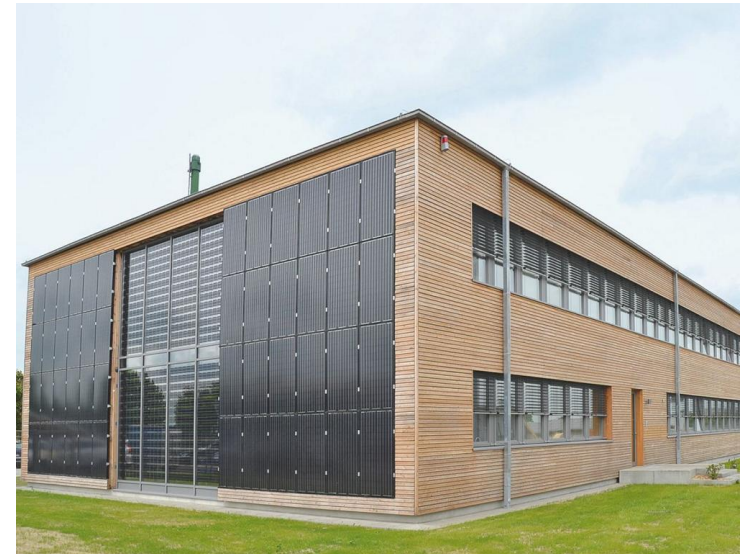
Beispiel Kombination Fassade und PV-Fassadenmodule
