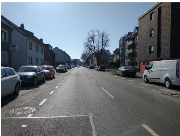
Ungünstige Relation Schutzstreifenbreite / Fahrbahnbreite
