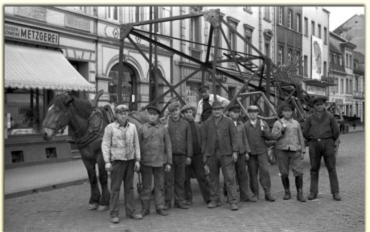
Pferdetransport einer Stahlkonstruktion über den Brühler Markt.
